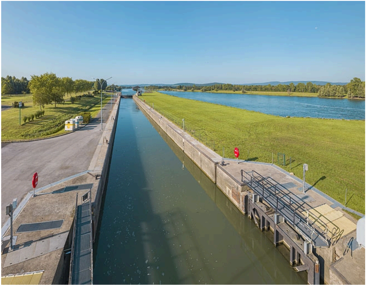
Le sas vu depuis la passerelle du barrage.
