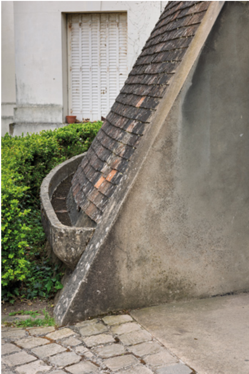
Jardinière à la base de la toiture.
