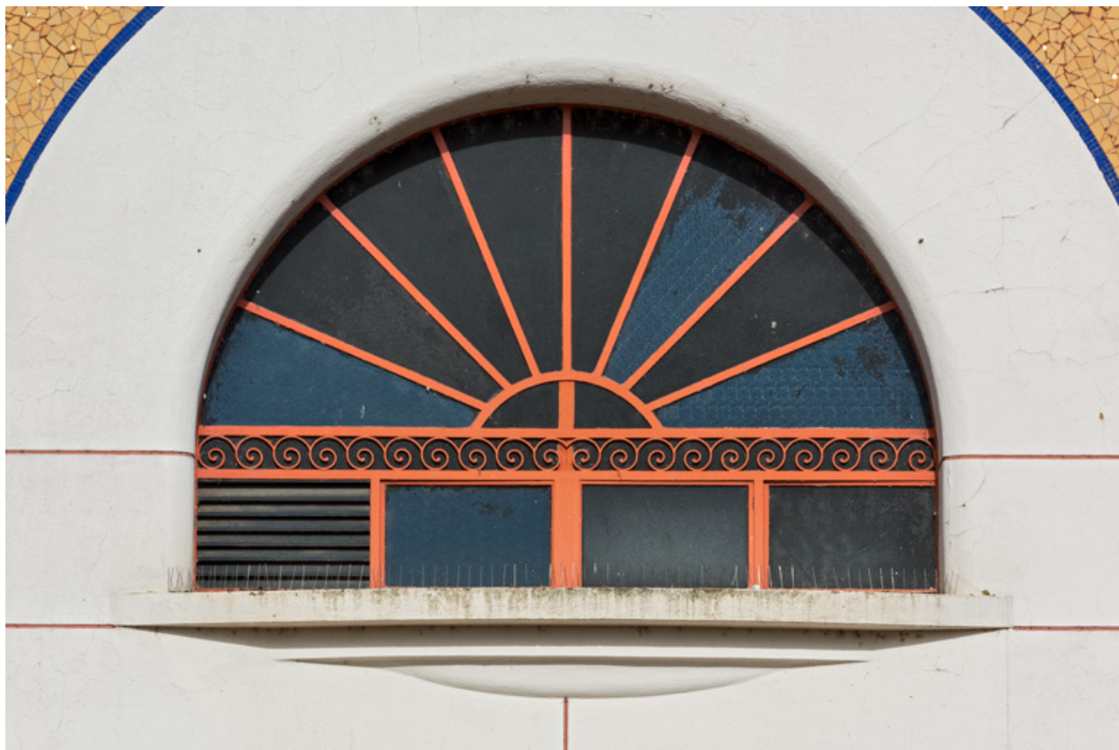
Façade antérieure, partie haute : baie.
