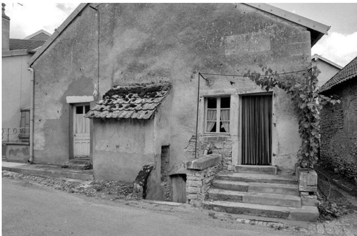
Maison située rue de Bresilley.
