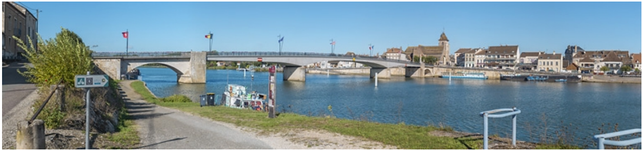
Vue d'ensemble depuis Losne, rive gauche.
