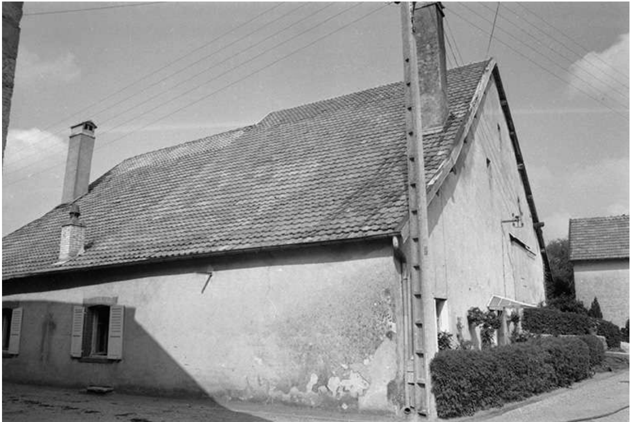
Ferme située rue de Tarcenay.
