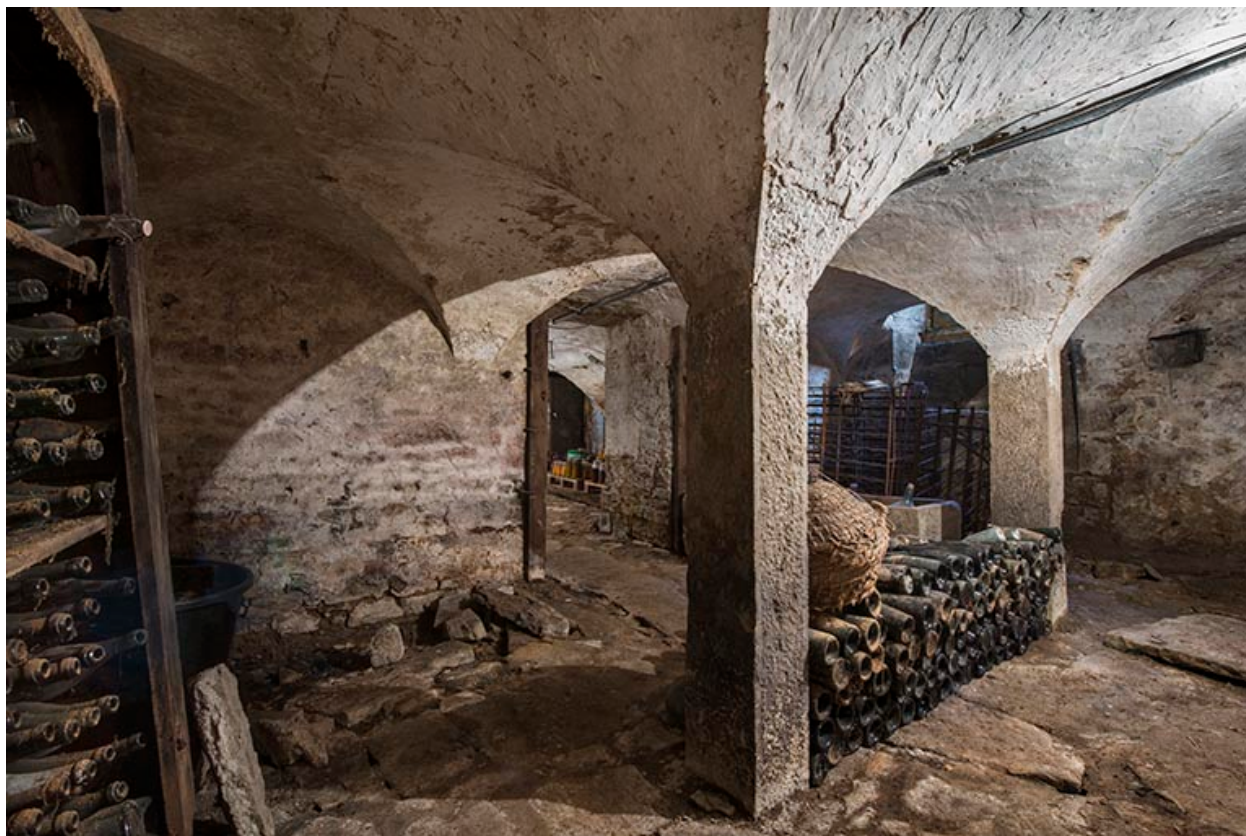
La cave, partie voûtée sur colonnes.
