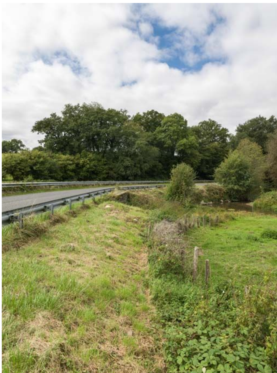
Vue de l'aqueduc.
