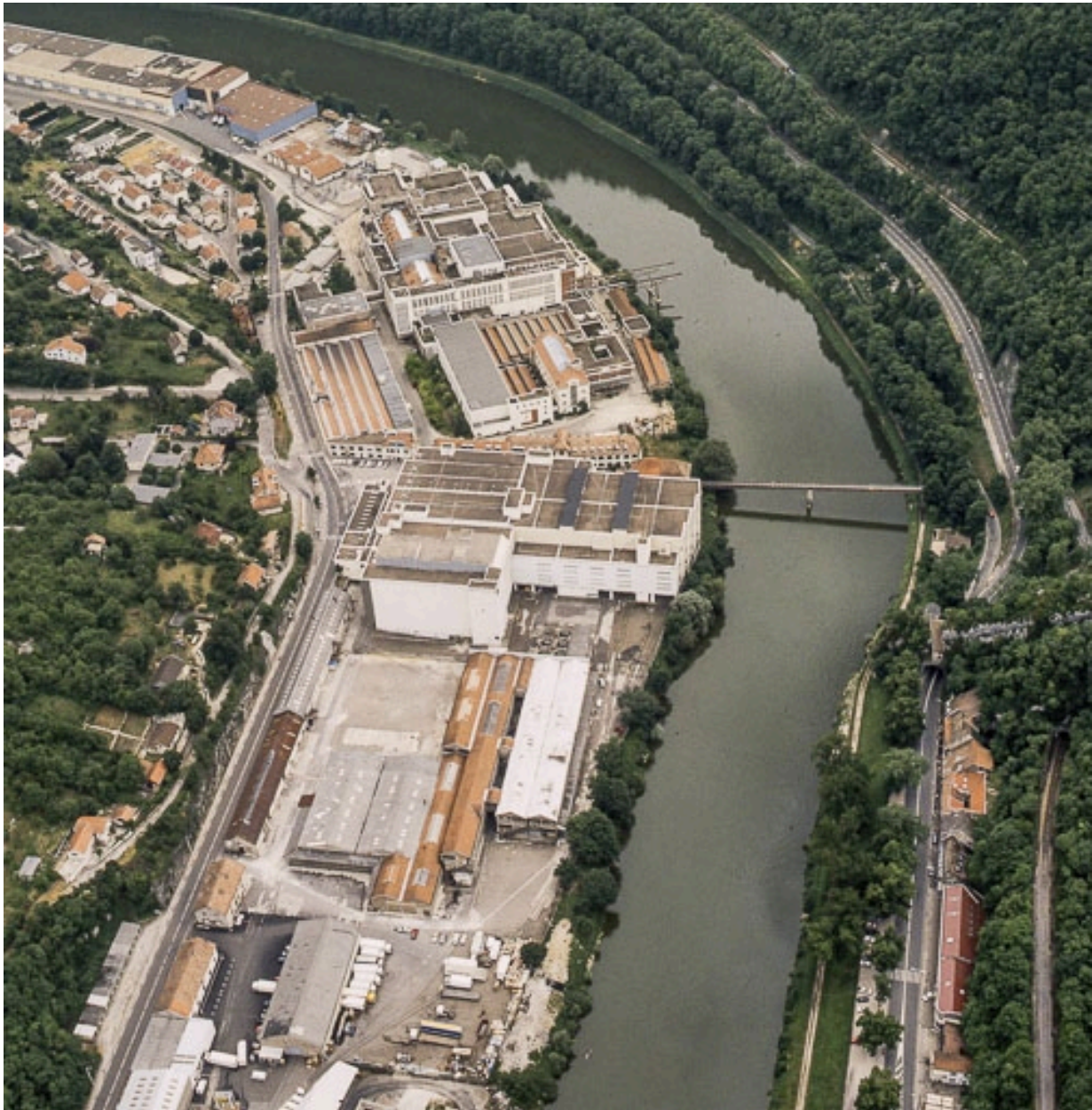
Vue aérienne du site depuis le nord-ouest.
