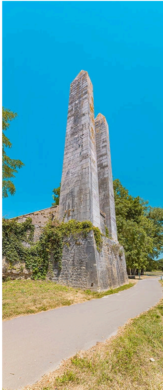
Pylônes de la rive droite, le long de la digue de Chauvort. Echelle de crue.
