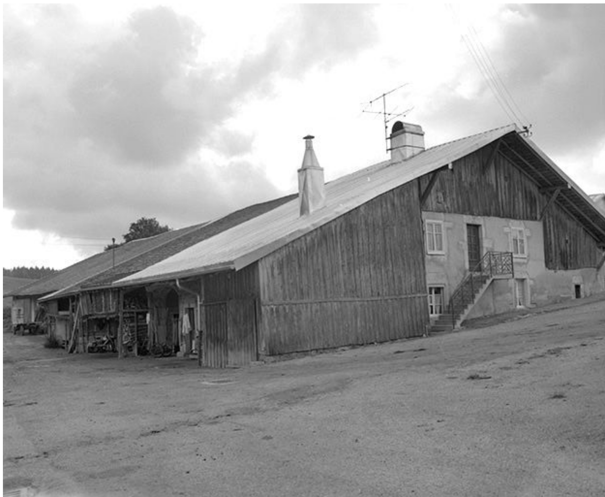
Façades antérieure et latérale gauche.
