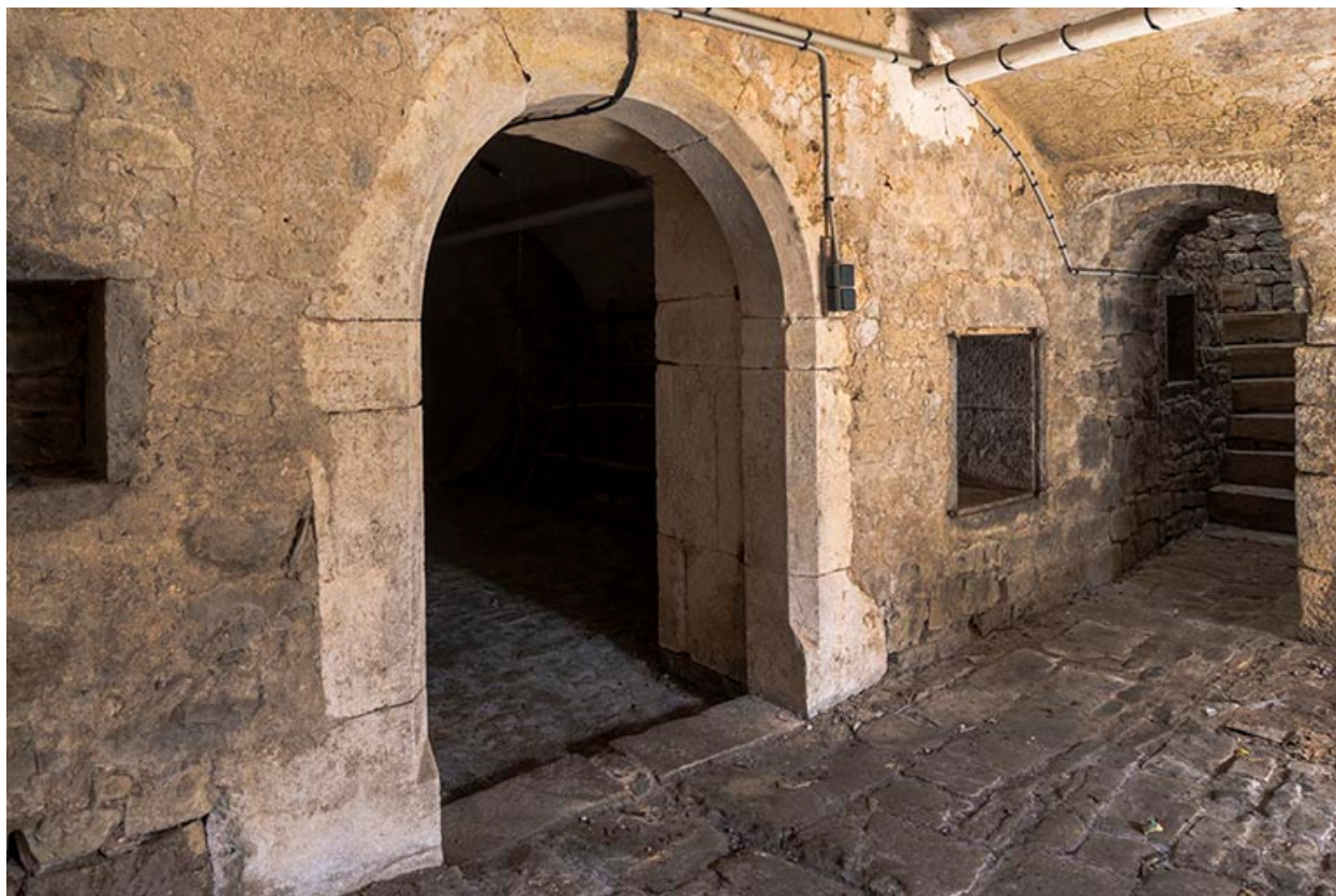
Porte de séparation de la cave.
