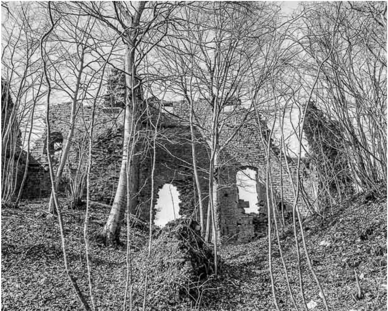
Vue générale des ruines du donjon.
