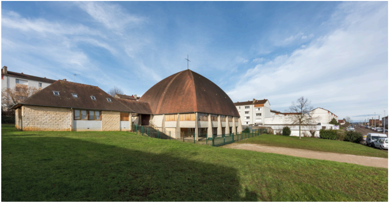
Centre paroissial. Vue d'ensemble de trois quarts.
