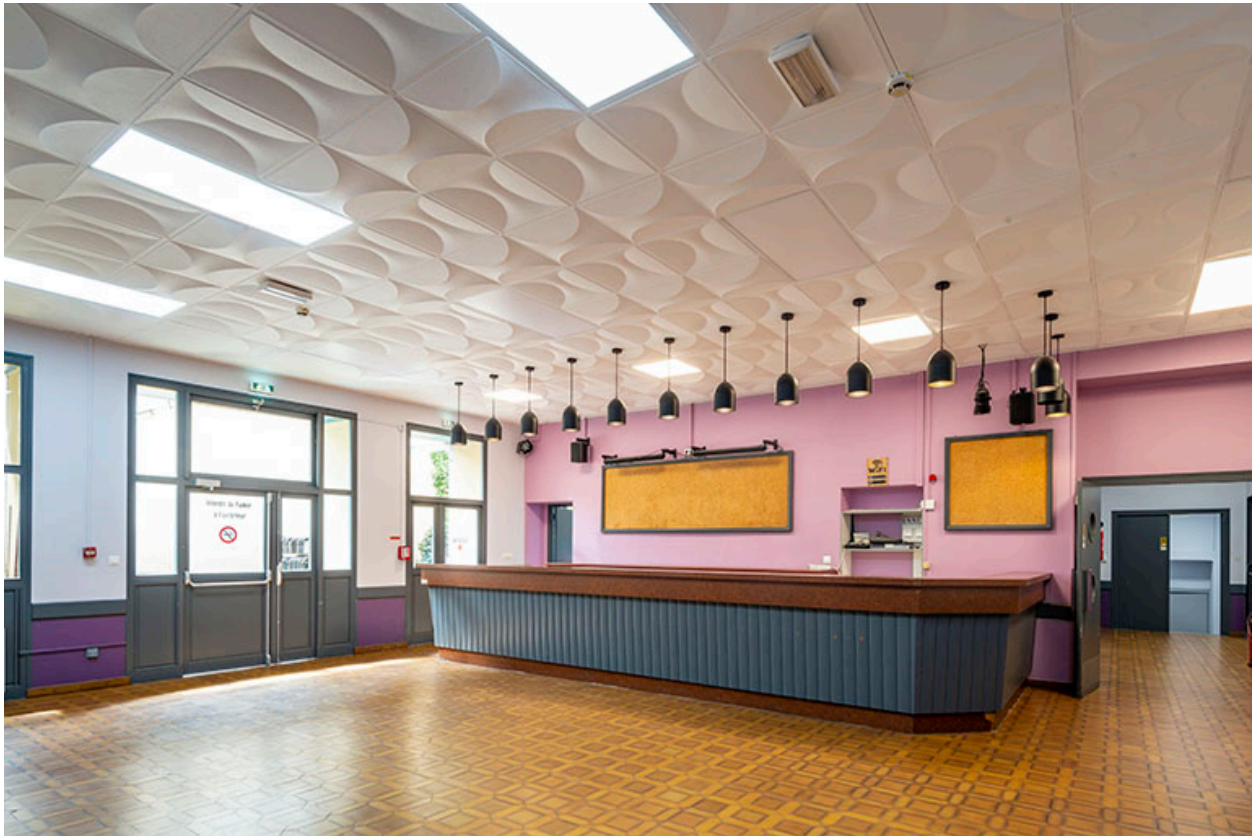
Bâtiment d'entrée, vestibule : bar.
