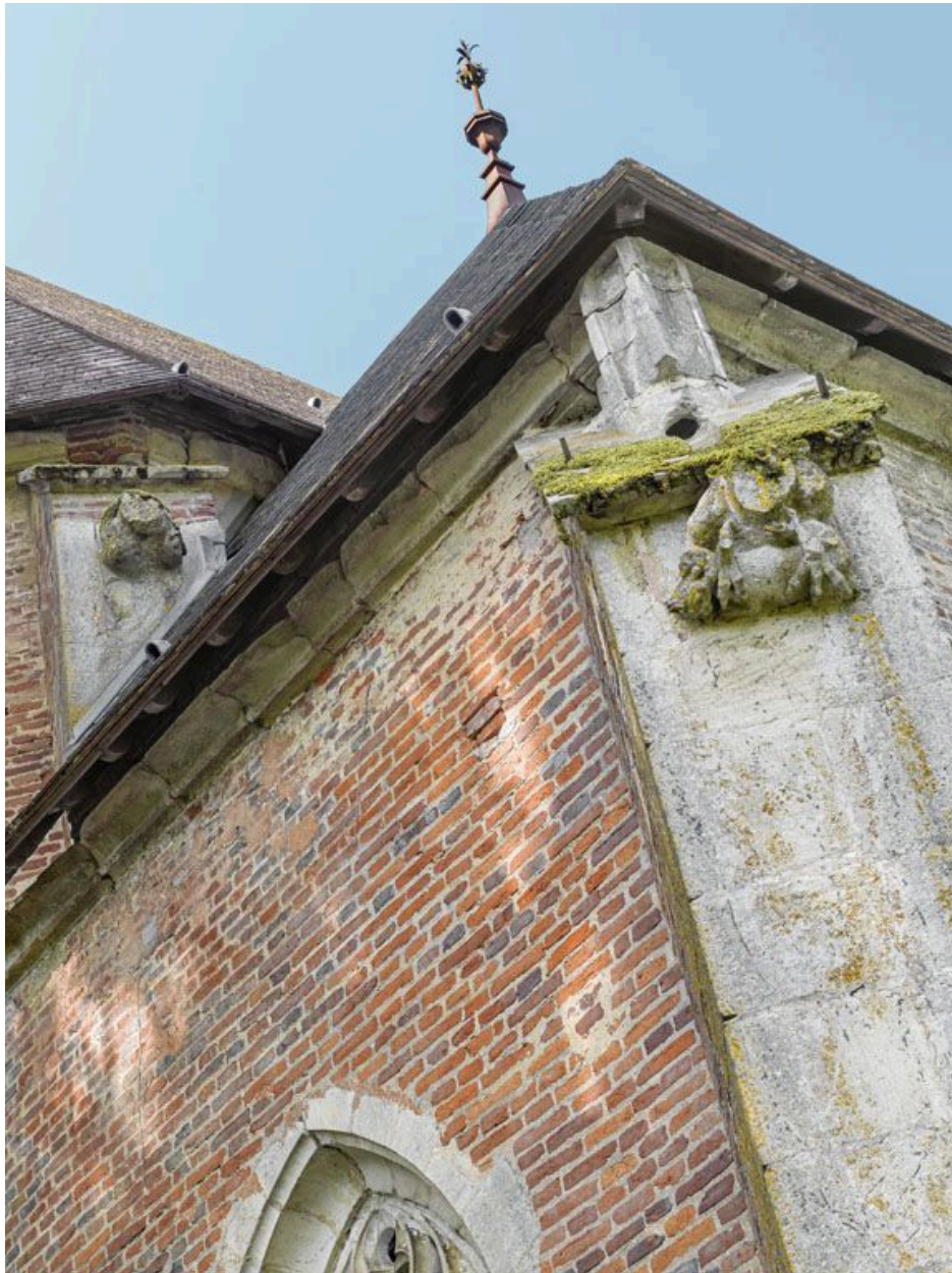
Gargouille sur le contrefort gauche de la chapelle gauche.
