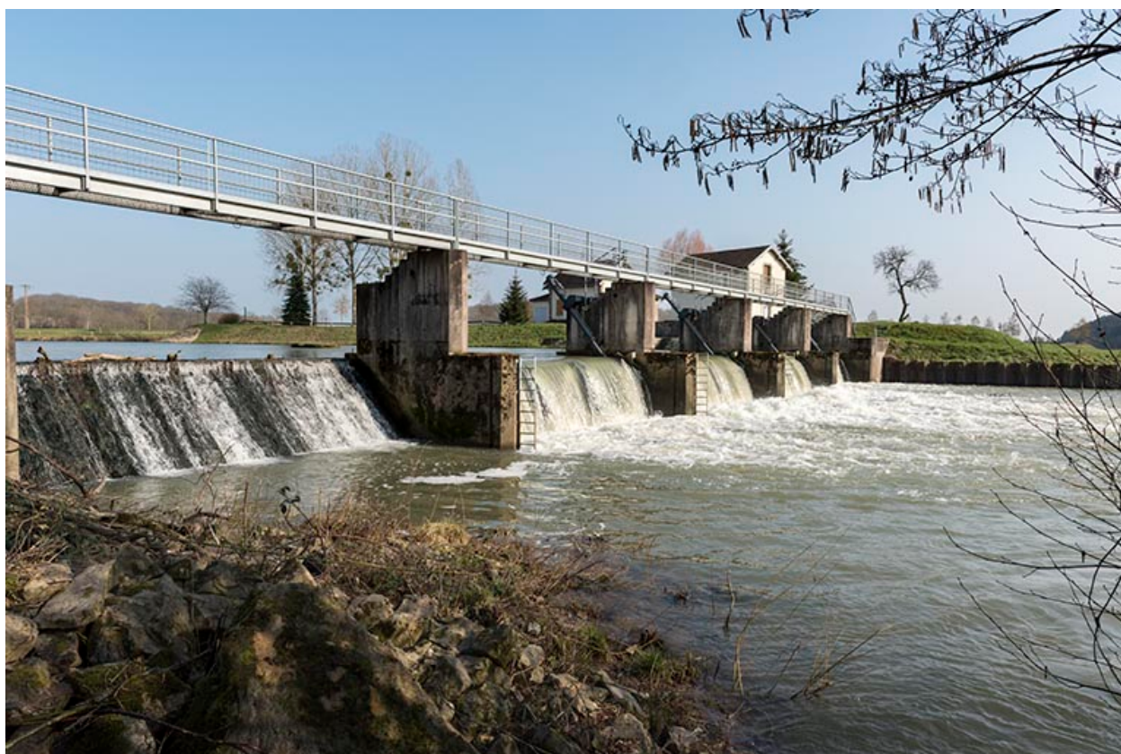
Le barrage mobile de Montureux-lès-Baulay.
