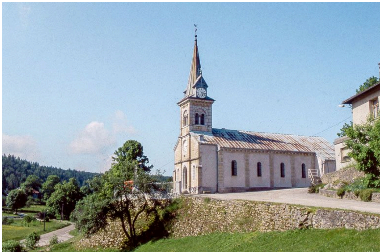
Façade antérieure et face droite.
