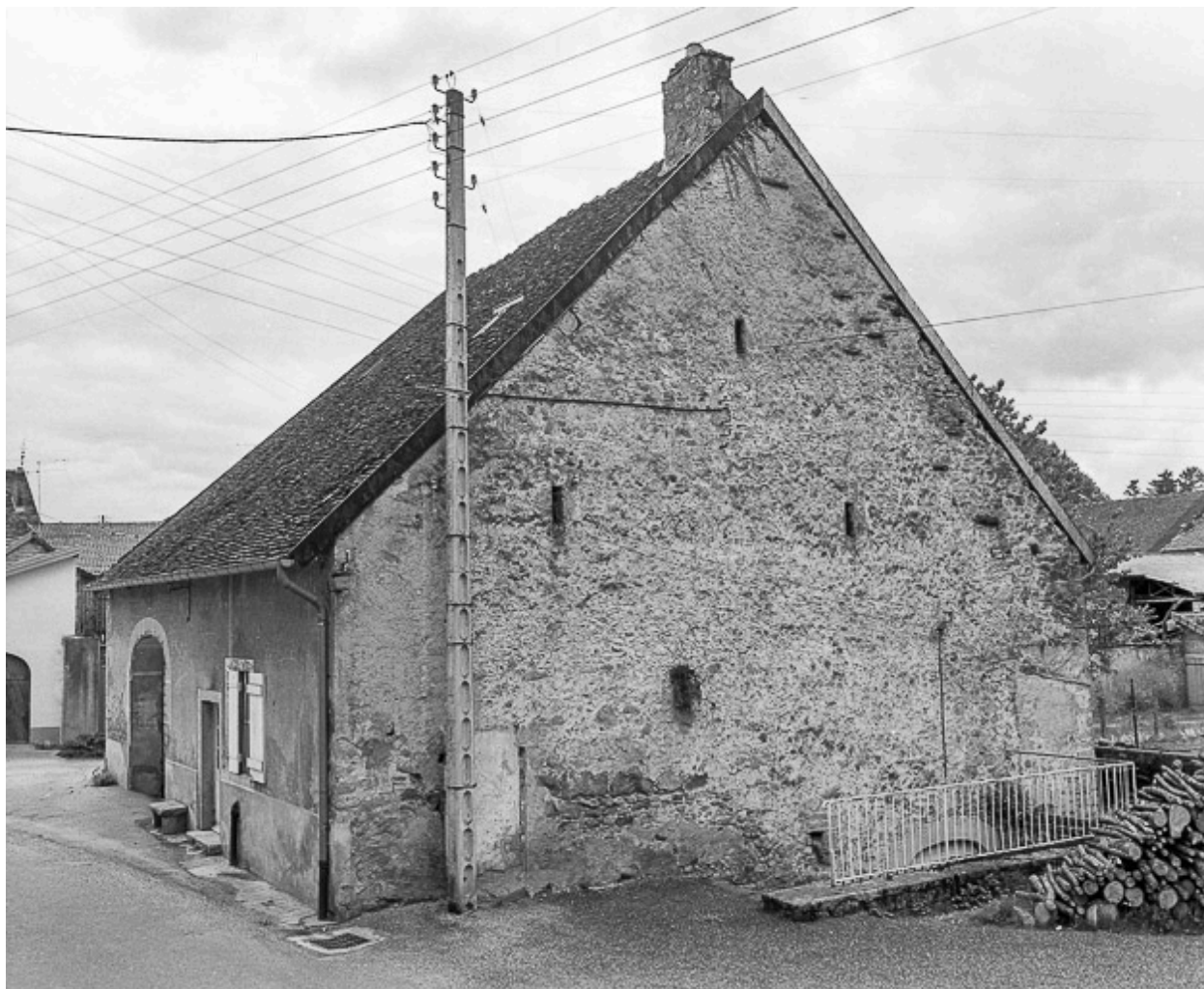
Façades antérieure et latérale droite.
