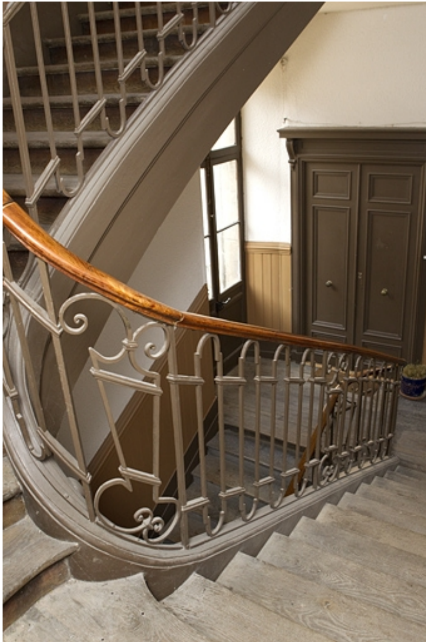
Vue de l'intérieur de l'escalier.
