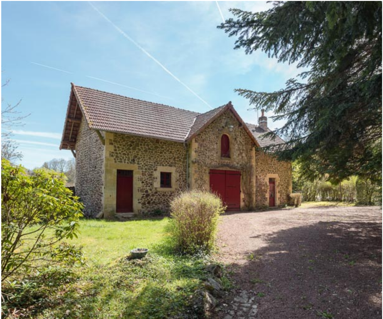
Façade principale donnant sur la villa.
