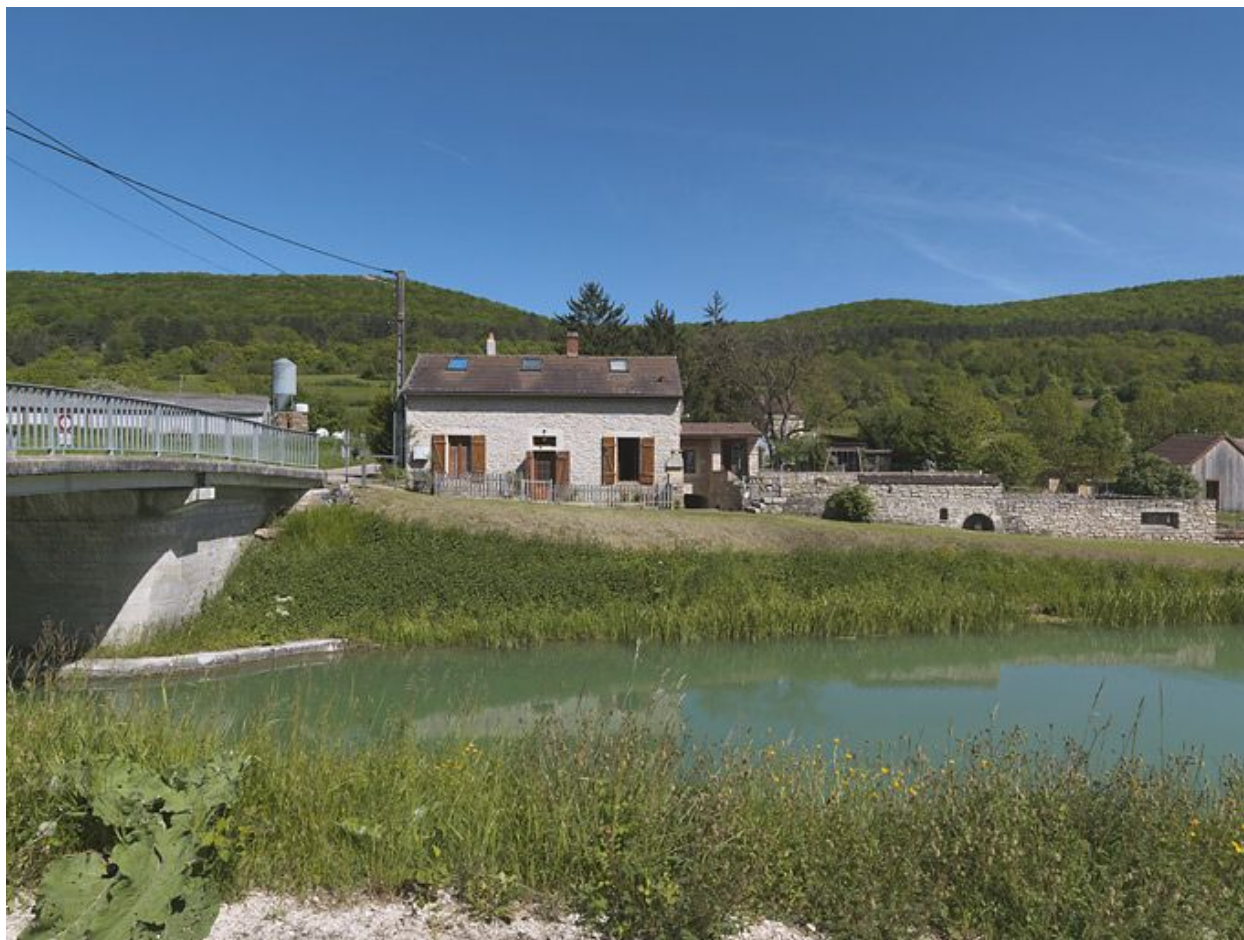
Maison de garde de face.
