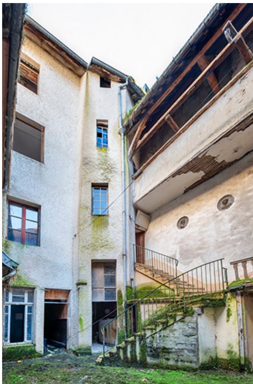
Vue depuis le nord-ouest de la cour : tour d'escalier et mur sud.
