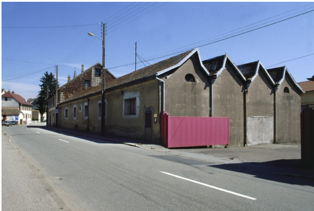
Atelier de fabrication longeant la rue d'Etueffont.
