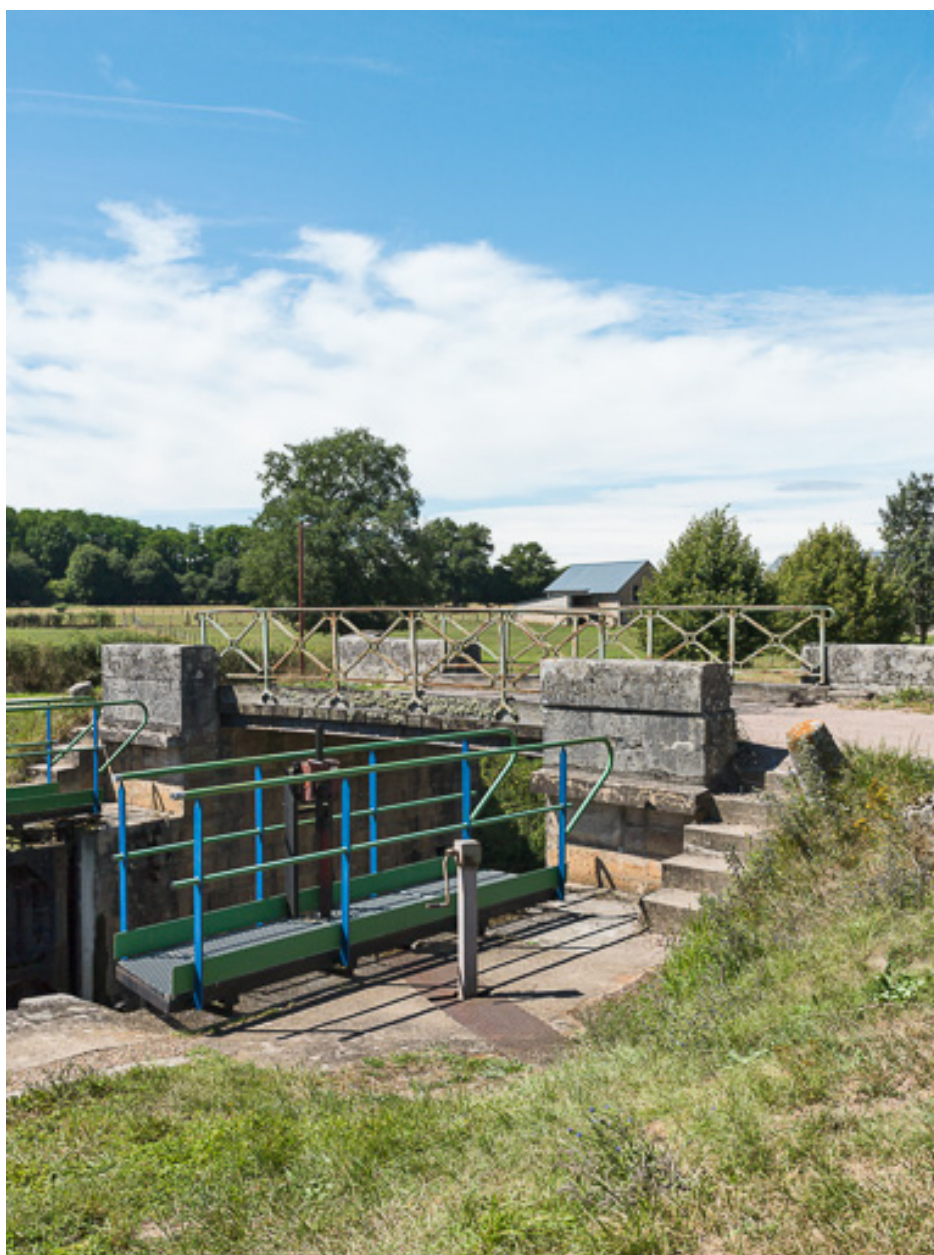
Vue rapprochée du pont et des escaliers.
