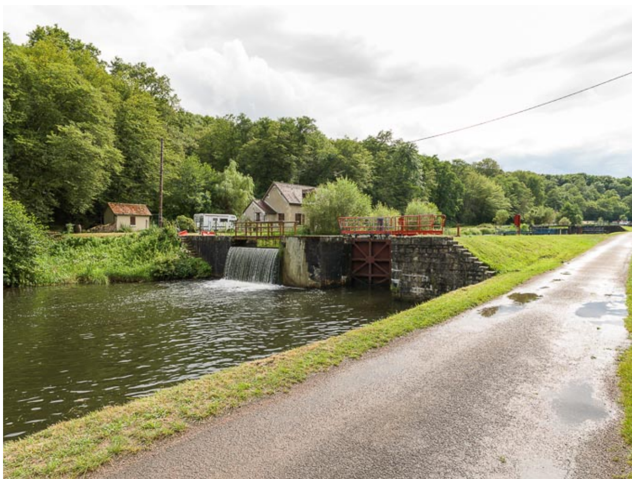
Vue du déversoir de superficie.
