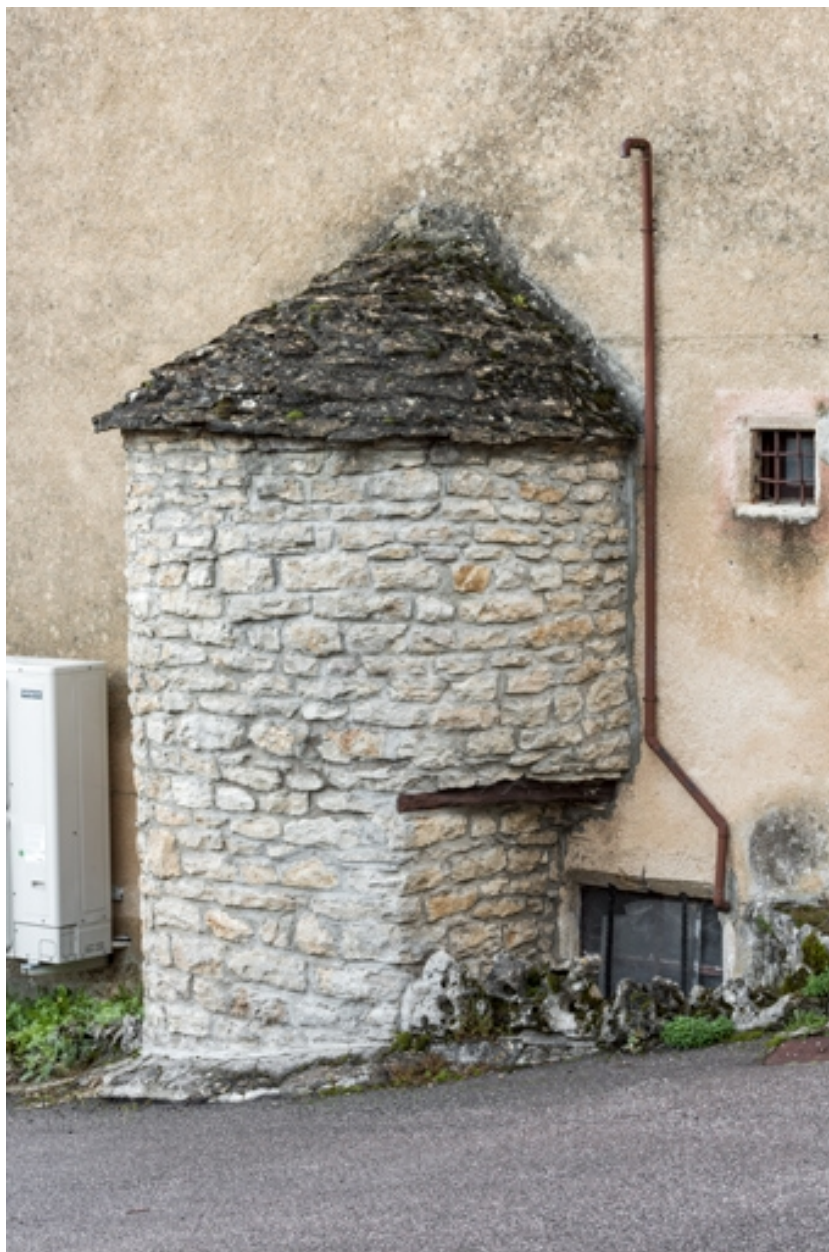
Vue du four à pain côté sud-ouest.
