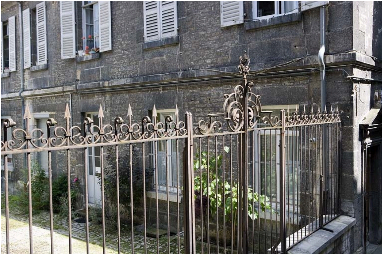
Vue de la grille séparant les deux cours, de trois quarts gauche.
