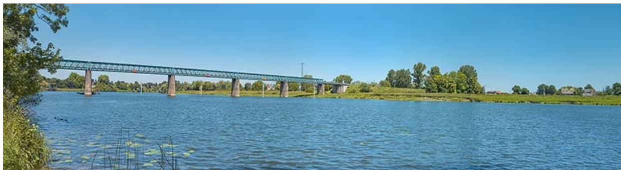
Vue d'ensemble d'amont.
