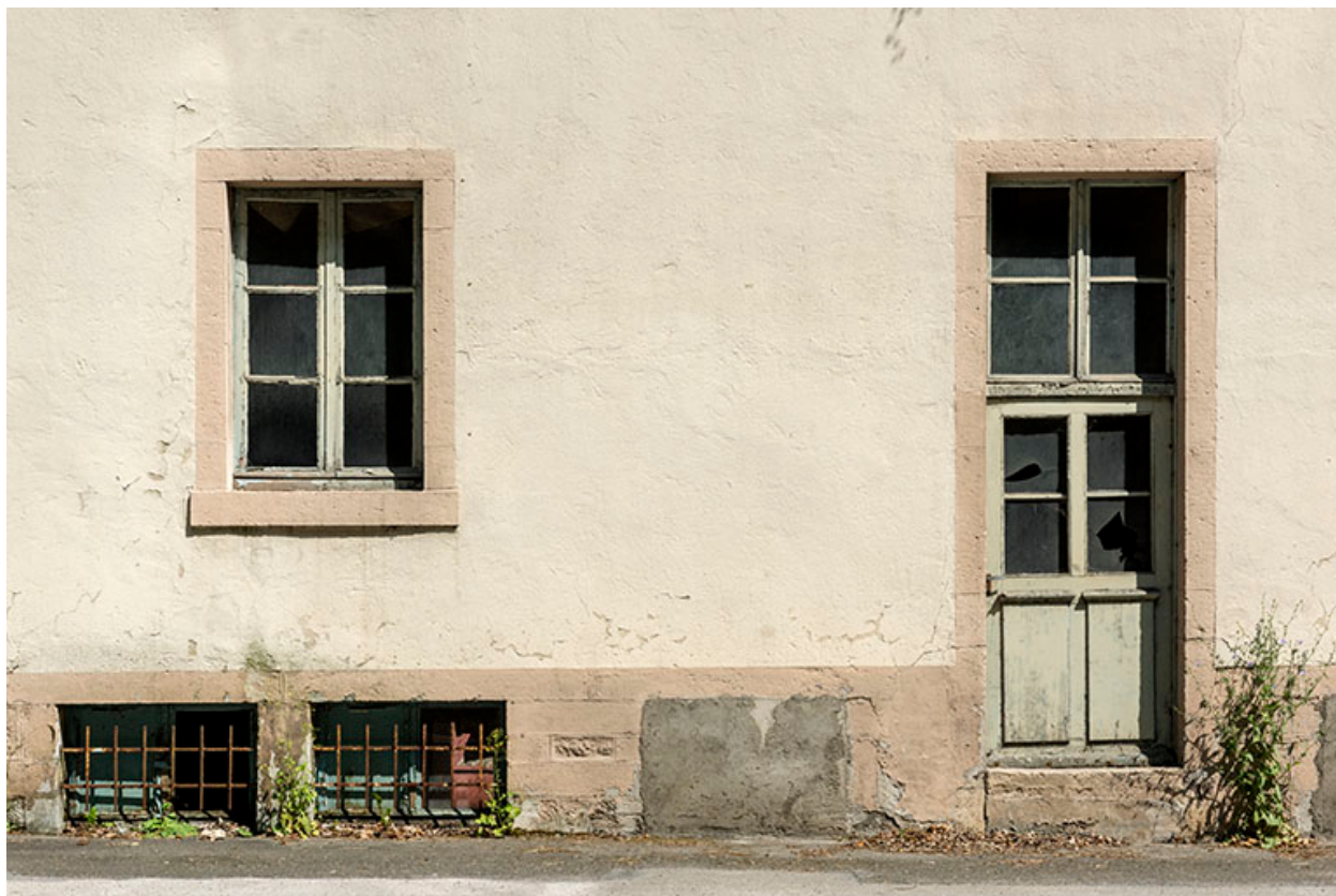
Bureau, façade antérieure : détail.
