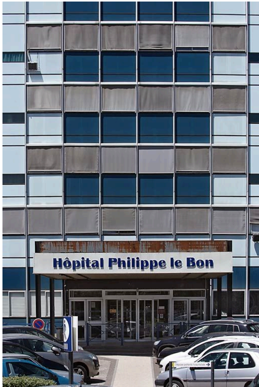
Bâtiment principal, détail de la façade.
