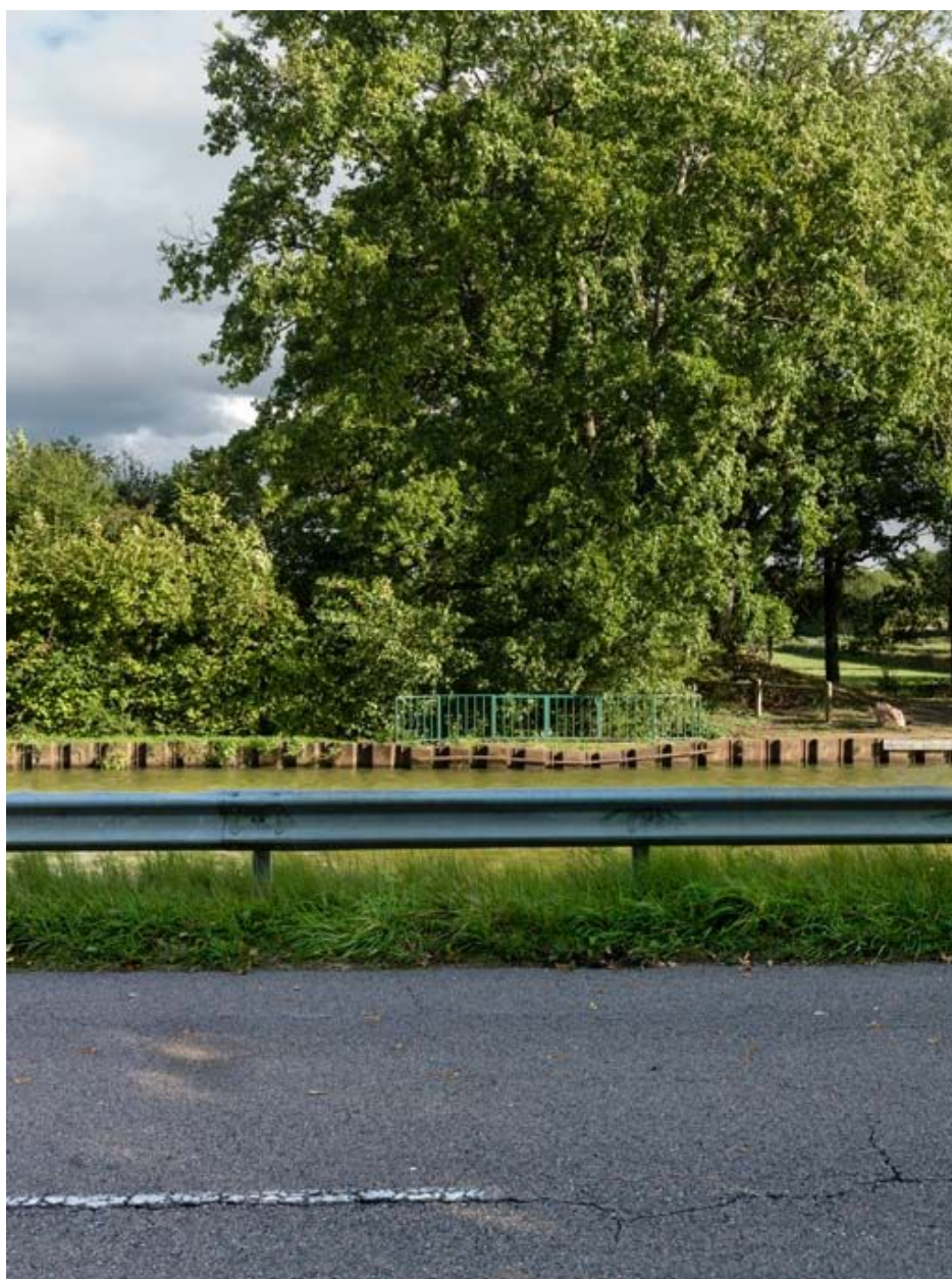
Vue de l'aqueduc.
