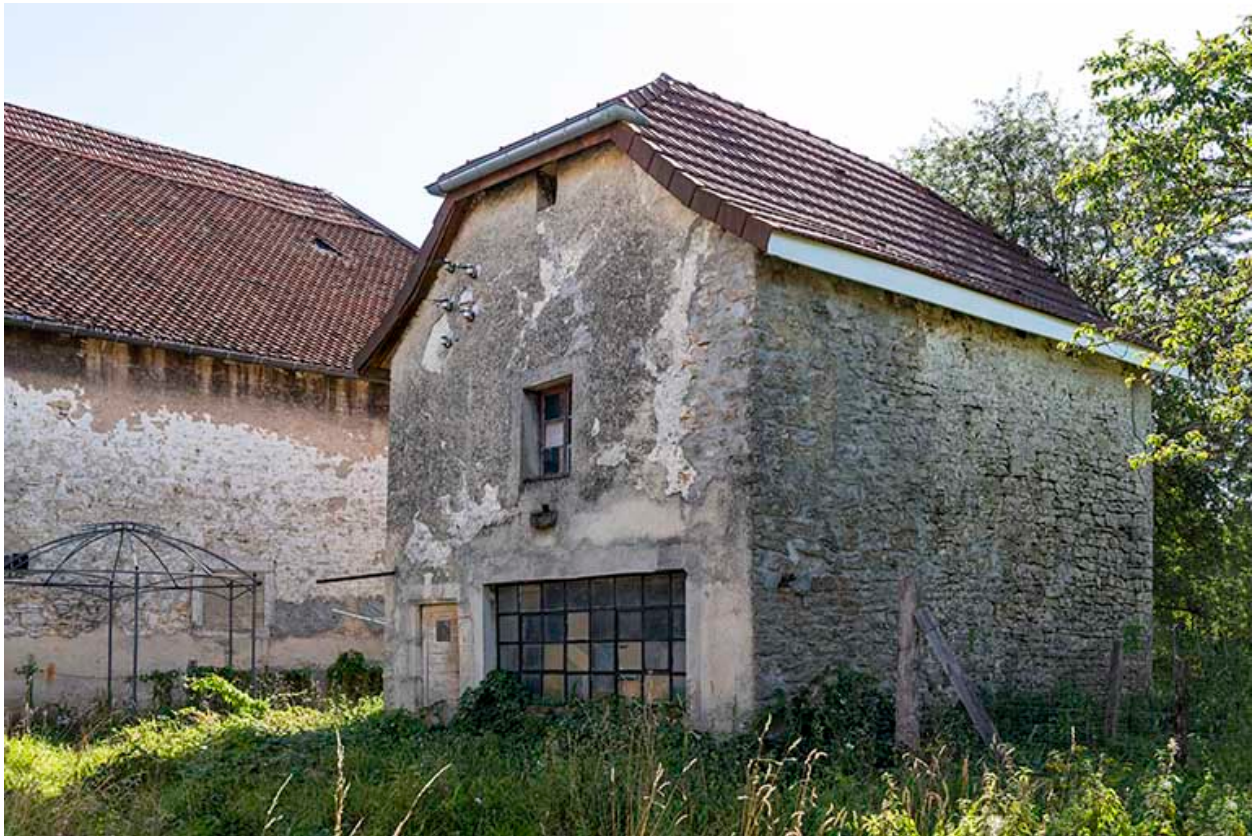
Forge : façades antérieure et latérale droite.
