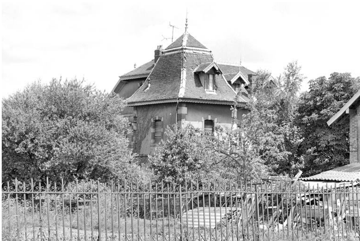
Toitures du logement patronal.
