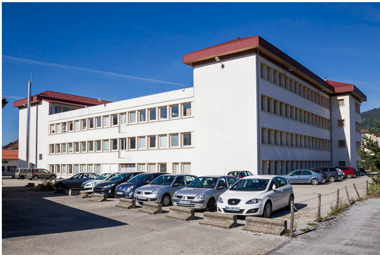
Usine : façades postérieure et latérale gauche.
