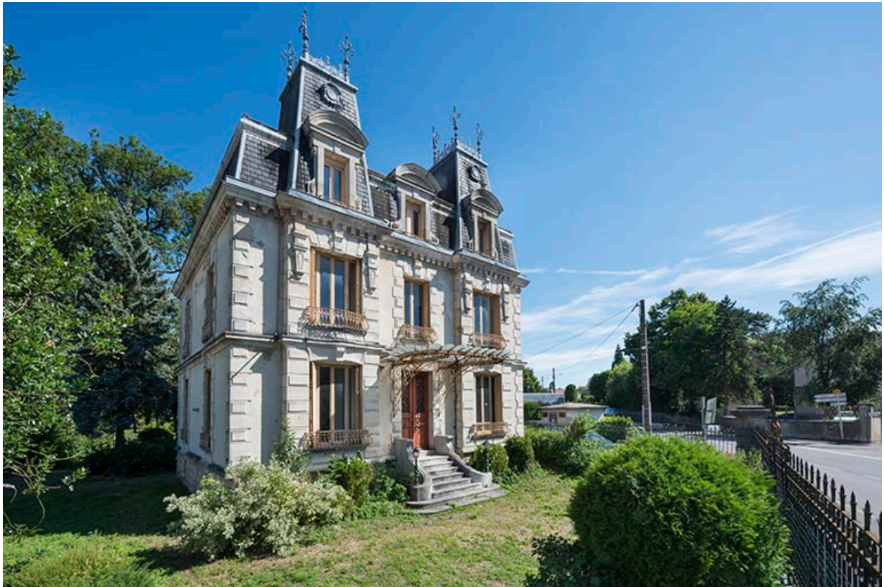
Vue d'ensemble de la maison, depuis le sud-ouest.
