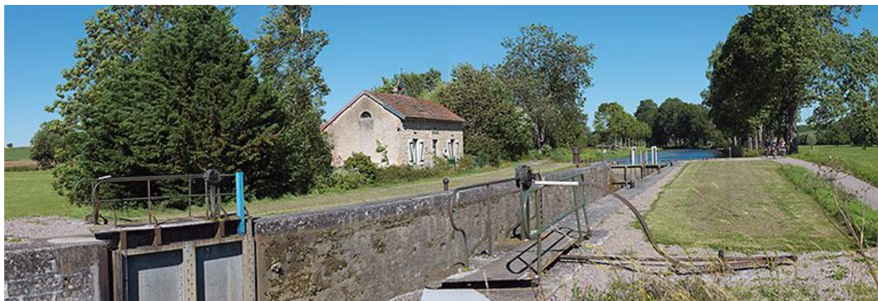
Vue d'ensemble du site pris d'aval.
