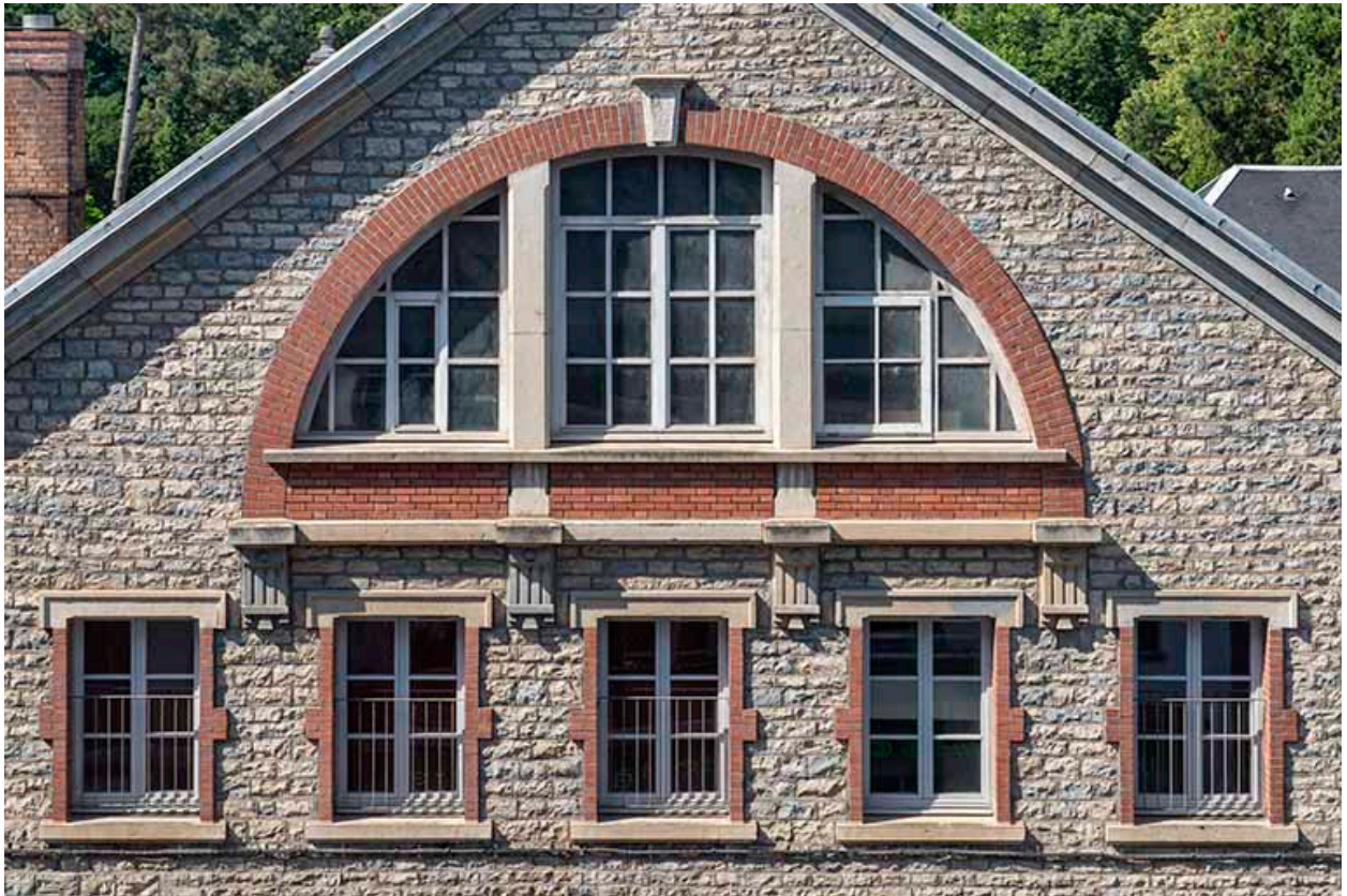
Façade sur la rue de la Mouillère, fenêtre thermale.
