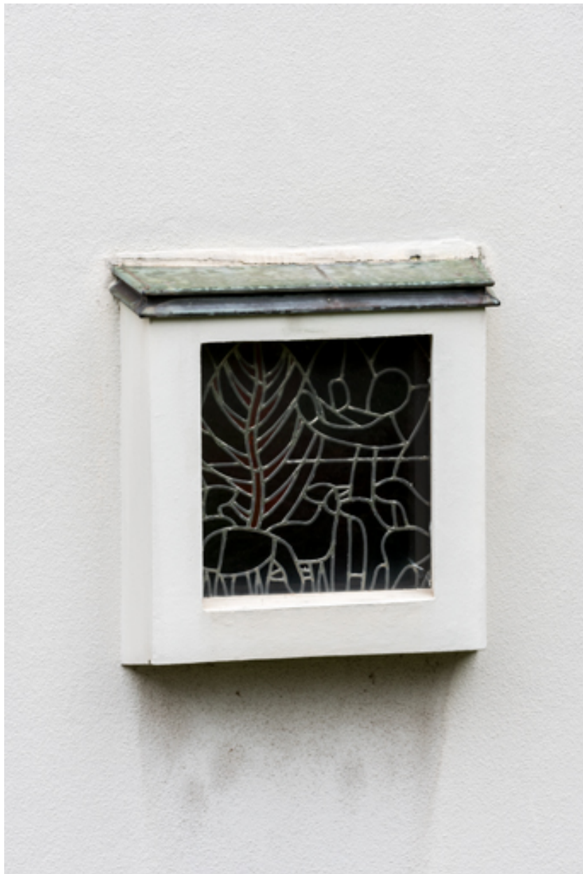
Vue extérieure de la verrière en vitrail (baie 0 - gauche).
