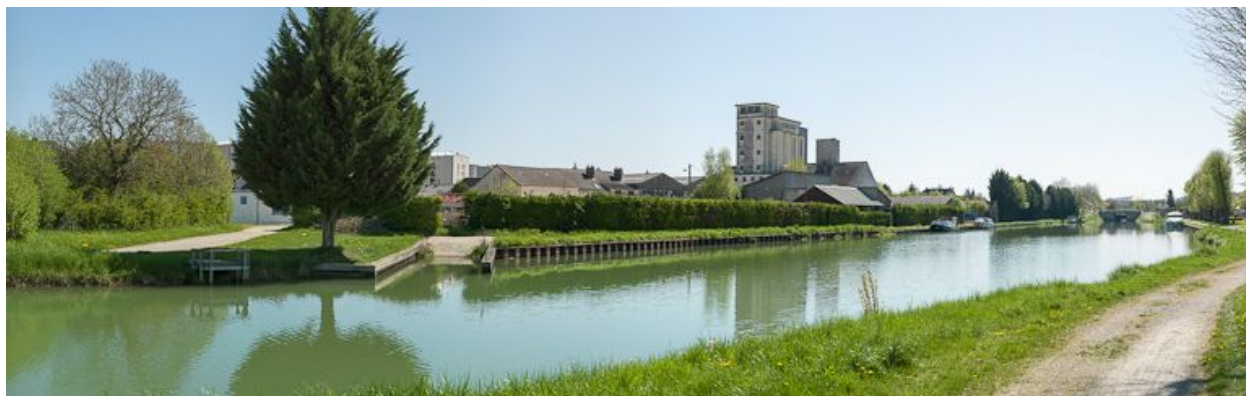
Le port vu d'aval.
