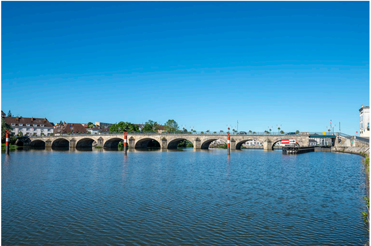
Vue d'ensemble du pont en pierre de Gray.
