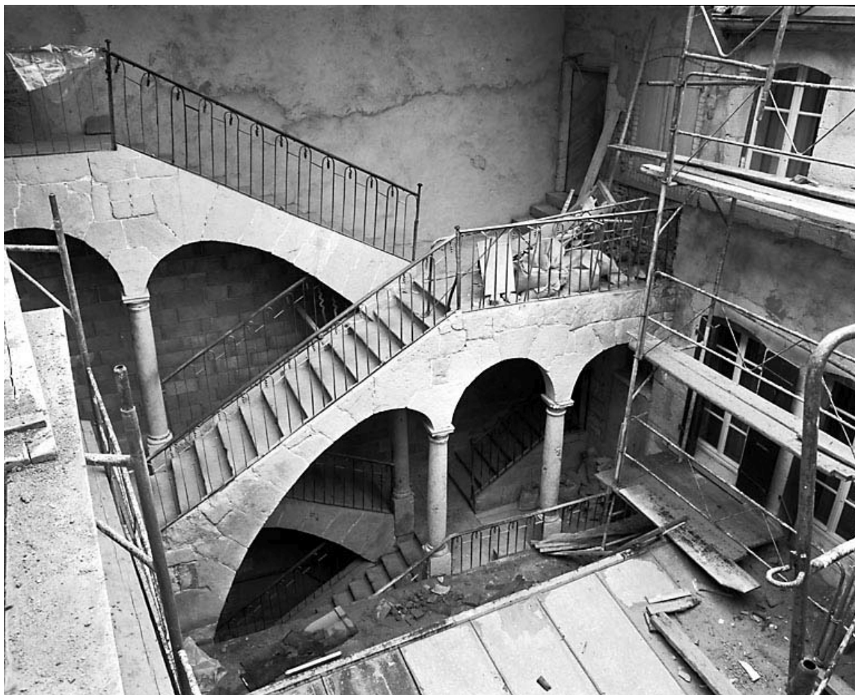
Escalier sur cour intérieure.
