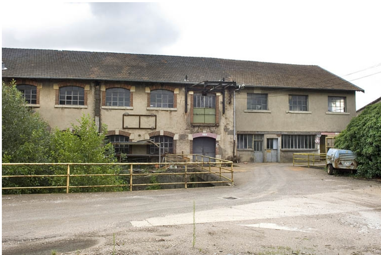
Façade ouest d'un atelier de fabrication (papeterie).
