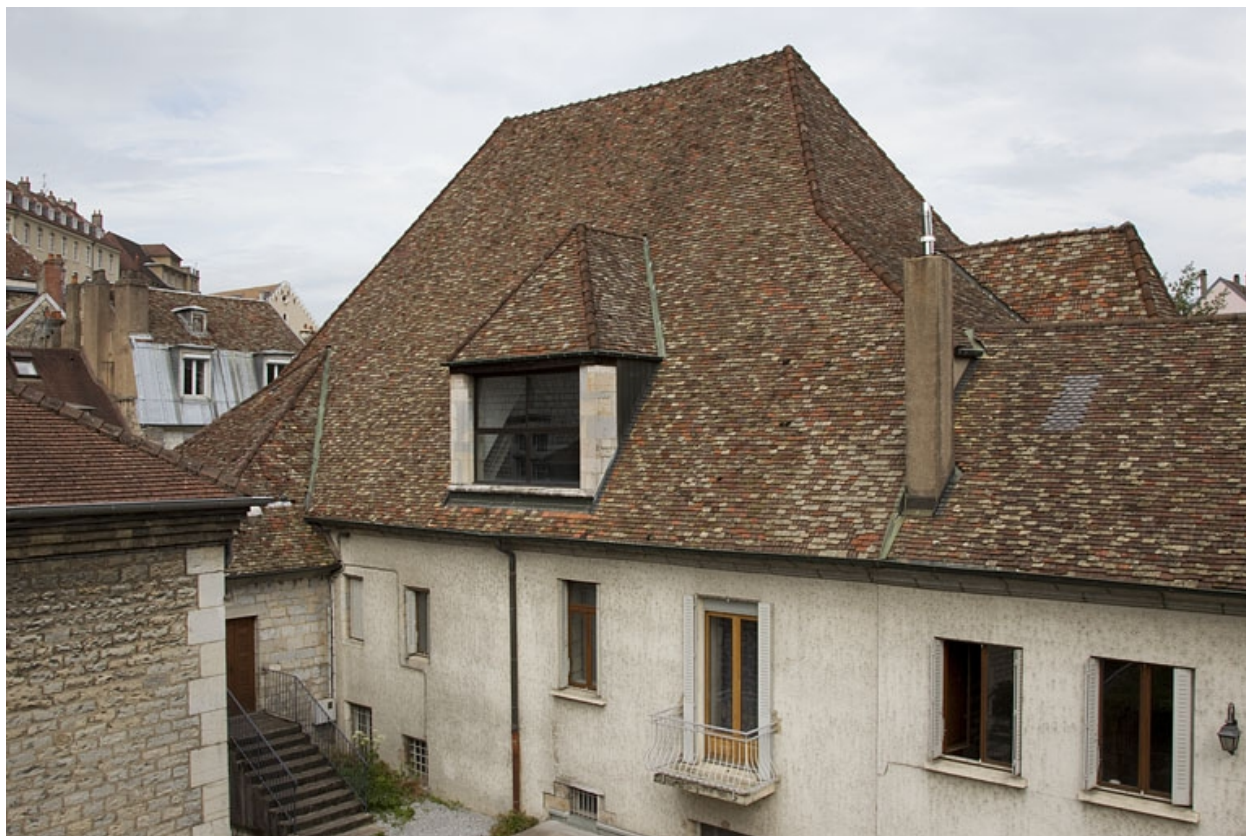
Façade latérale droite, de trois quarts droit.
