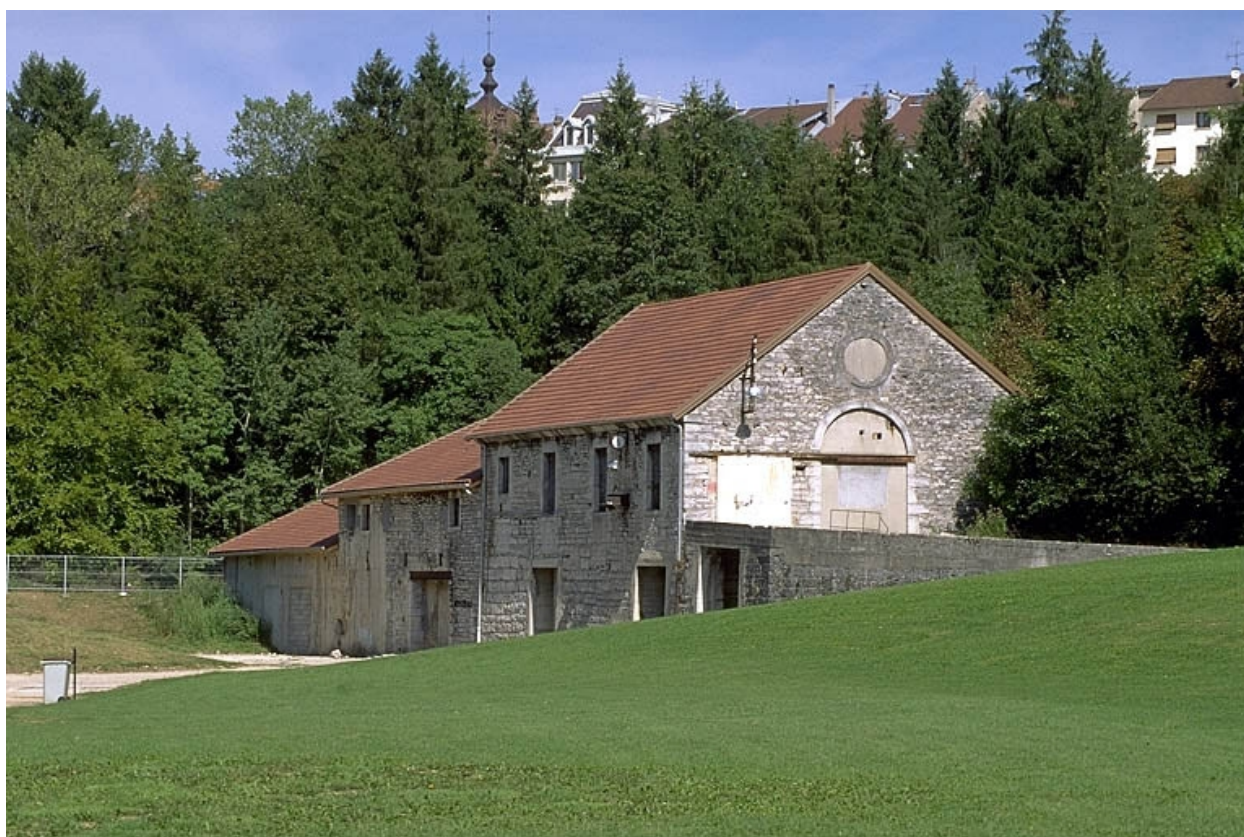
Ateliers de fabrication (galvanisation).
