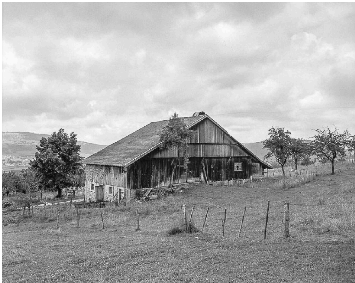
Ferme cadastrée 1966 AE 109 : façades postérieure et latérale droite.
