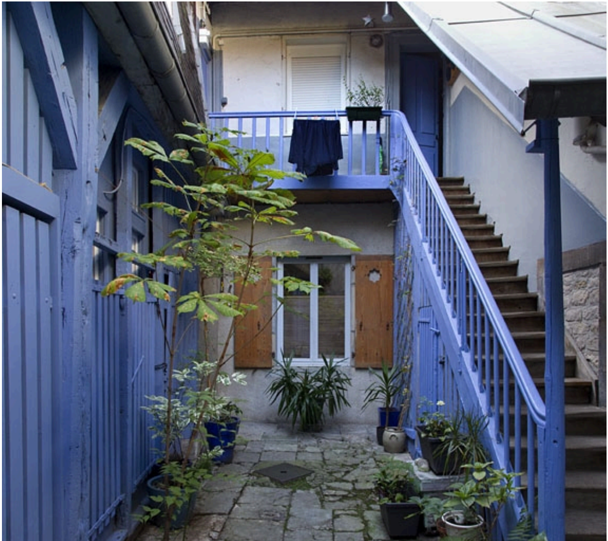
Deuxième logis secondaire, façade postérieure : détail de l'escalier extérieur.
