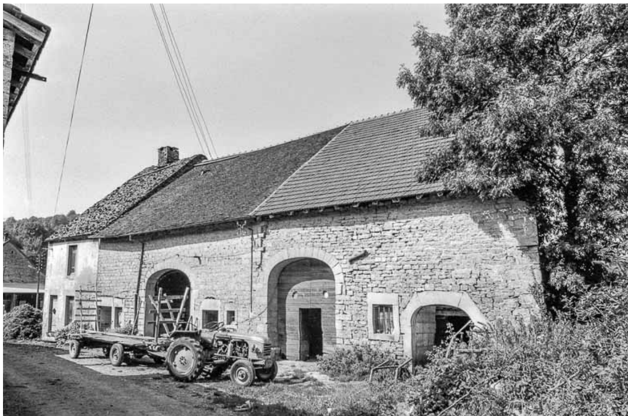
Ferme cadastrée ZK 40 : façade antérieure.
