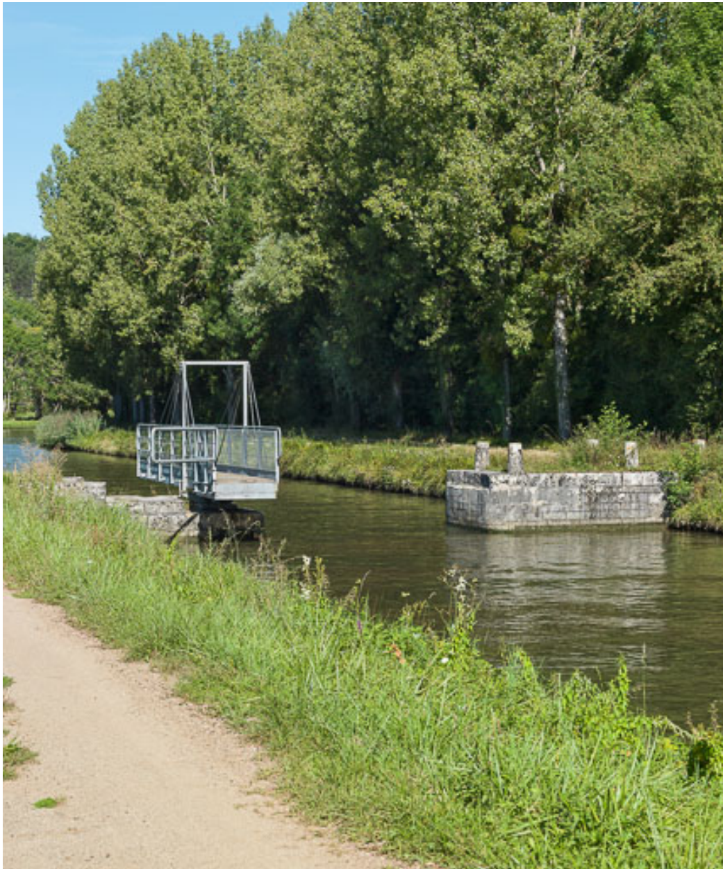
Vue d'ensemble de la passerelle.
