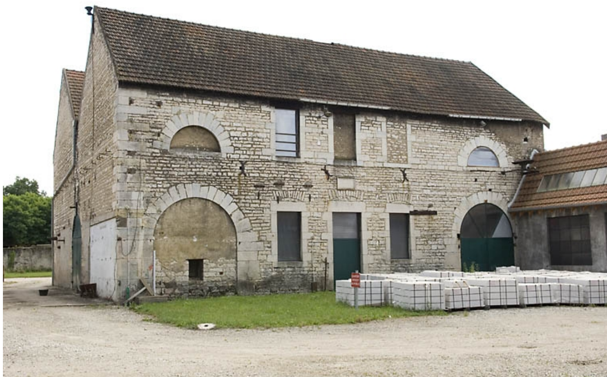
Bâtiment du haut fourneau est.
